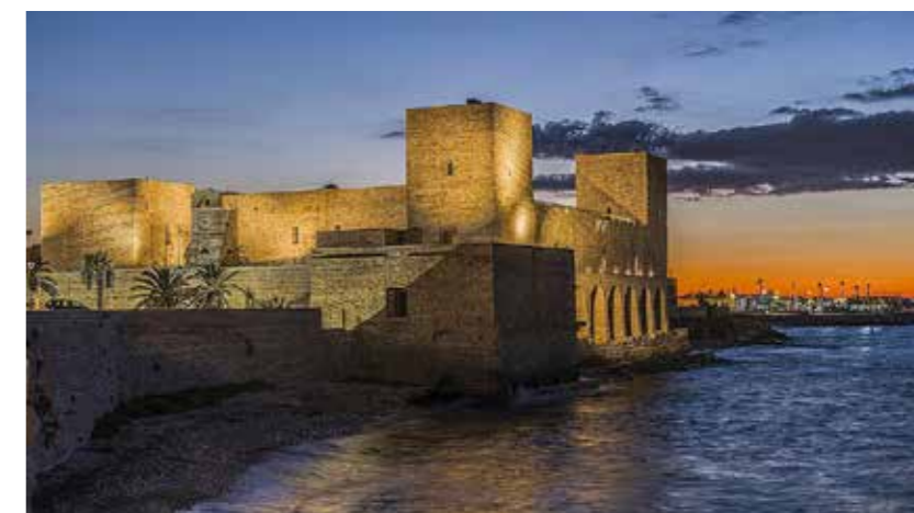
Il Castello di Trani al tramonto
